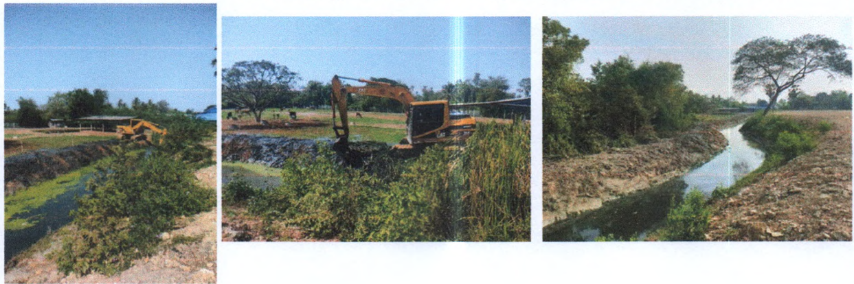
๙. โครงการก่อสร้างรางระบายน้ำ หมู่ที่ ๗ (บ้านพีเปี้ยก - สุดซอย) งบประมาณ ๓๐๐,๐๐๐ บาท
